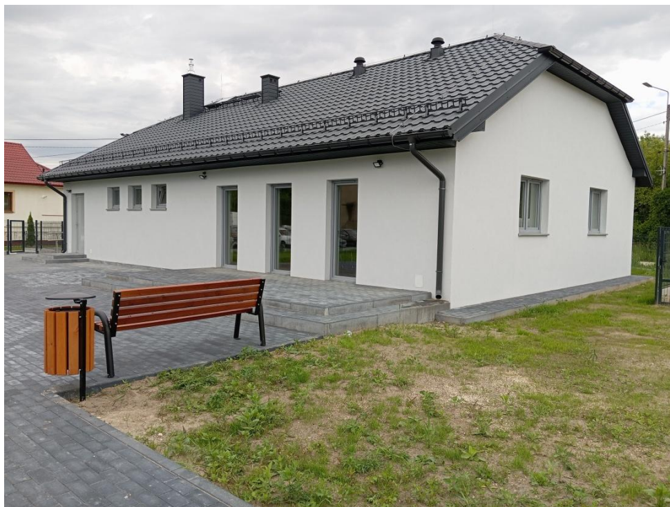
Zdjęcie 8. Wybudowana świetlica w miejscowości Skorzów.
