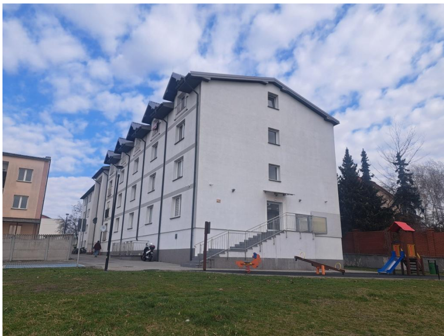
Zdjęcie 10. Budynek wielorodzinny przy ul. Boh. Warszawy w Busku-Zdroju.
