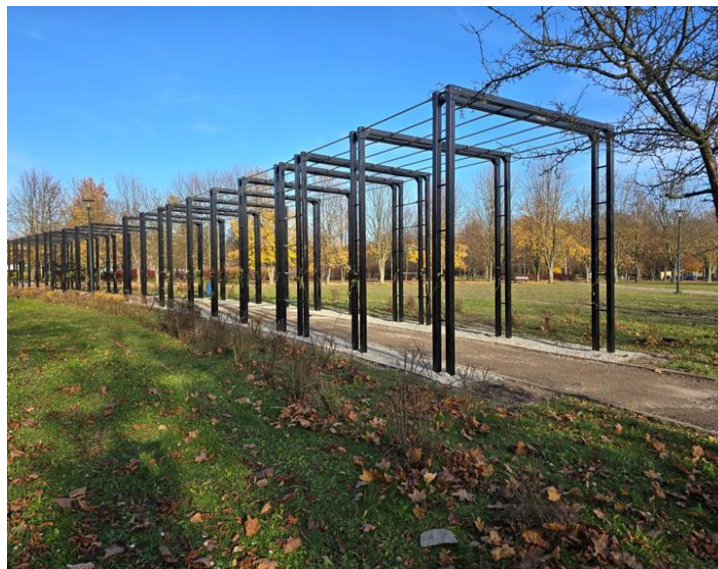
Zdjęcie 6. Pergole zamontowane nad alejkami w Nowym Parku Zdrojowym.
