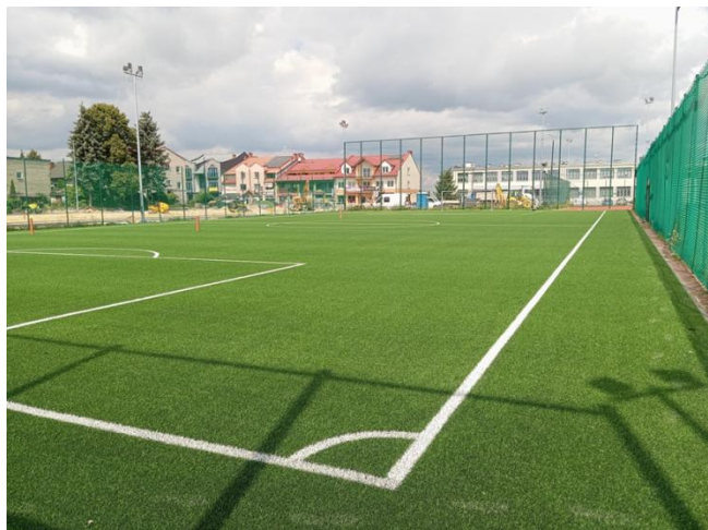
Zdjęcie 2. Nawierzchnia ze sztucznej trawy na boisku piłkarskim typu „Orlik 2012” po modernizacji, nowe oprawy oświetleniowe energooszczędne typu LED, piłkowsywyty i ogrodzenie przy boisku o nawierzchni ze sztucznej trawy.
