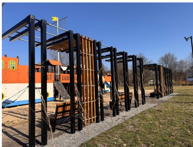
Zdjęcie 5. Trejaże/pergole o konstrukcji stalowej przy placu zabaw „statek”.
