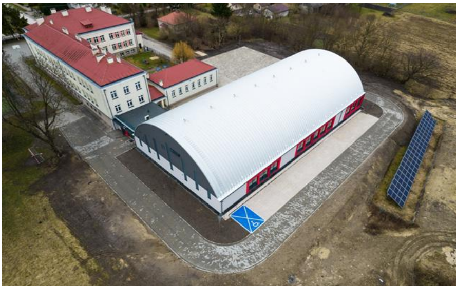
Zdjęcie 4. Boisko wielofunkcyjne wraz z zadaszeniem o stałej konstrukcji.
