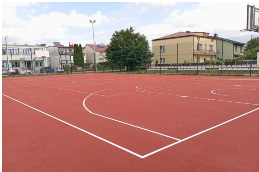
Zdjęcie 3. Nawierzchnia poliuretanowa na boisku do koszyków typu „Orlik 2012”.
